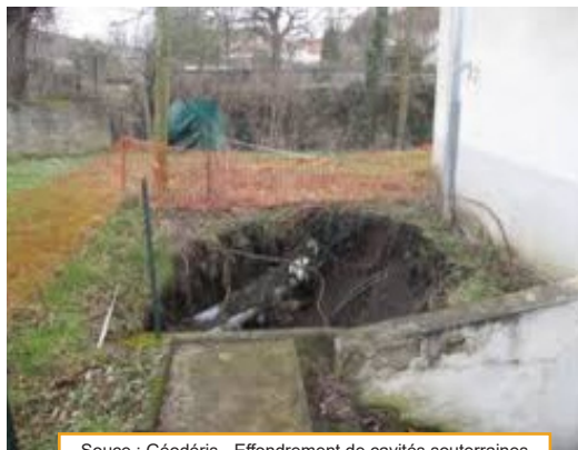
Source : Géodéris - Effondrement de cavités souterraines
